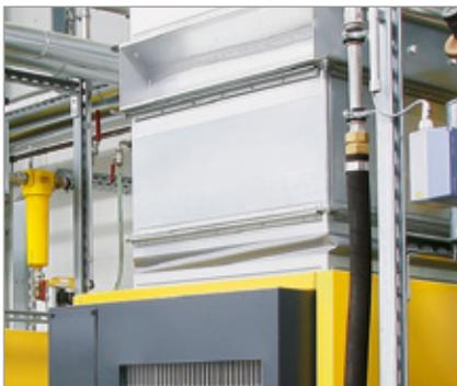
Fig. 2: Raccordo di aerazione del compressore con giunto di tela olona
