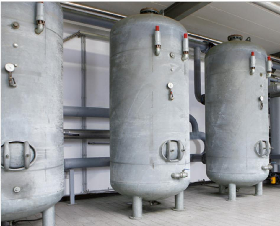
**Fig. 4:** Serbatoi di accumulo d'aria compressa
