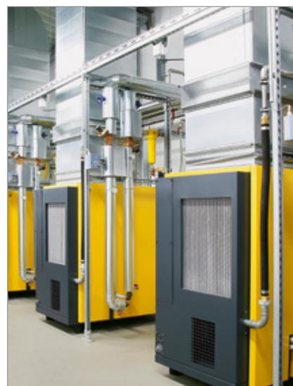
Fig. 2 Corretto allacciamento dei compressori a un sistema di recupero del calore
