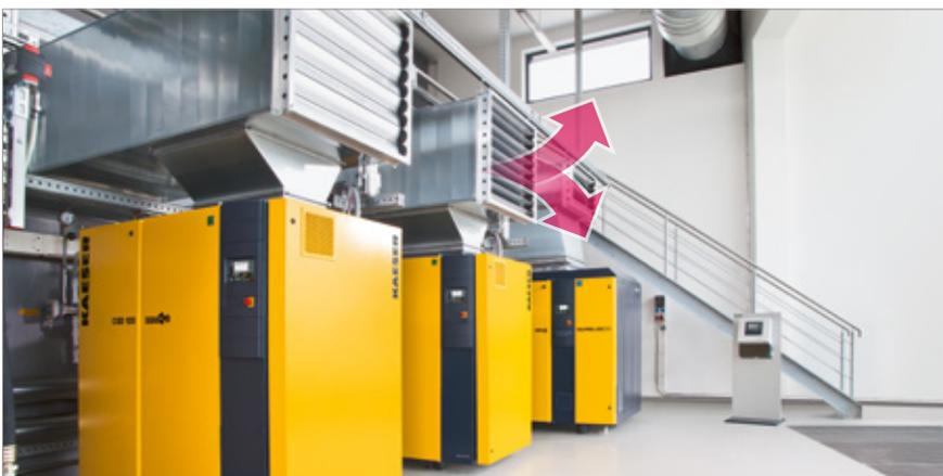
Fig. 3: Stazione d'aria compressa con sistema di aerazione a controllo termostatico
