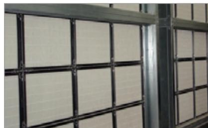
Fig. 2b: Sistema di filtraggio dell'aria di raffreddamento
